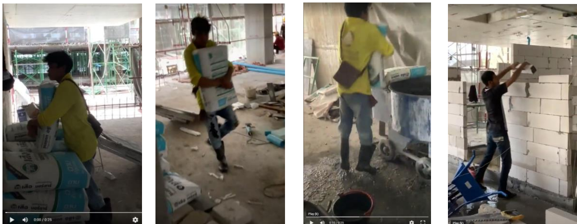
ภาพที่ 5.7 ตัวอย่างสิ่งของและวัสดุที่ต้องมีการยกและเคลื่อนย้ายในพื้นที่ก่อสร้าง
