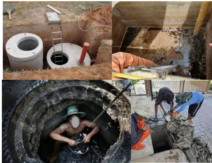
ภาพที่ 2.4 การเข้าไปทำงานในบ่อ หลุม
