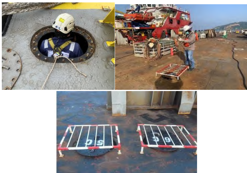
ภาพที่ ค-4 ตัวอย่างการจัดทำฝาปิด Man-hole และแผ่นครอบกันคนตกในช่อง Man-hole ที่เรือ Barge
