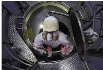
ภาพที่ 2.8 ตัวอย่างการเข้าไปทำงานในท่อที่ช่องทางเข้าออกที่จำกัด
